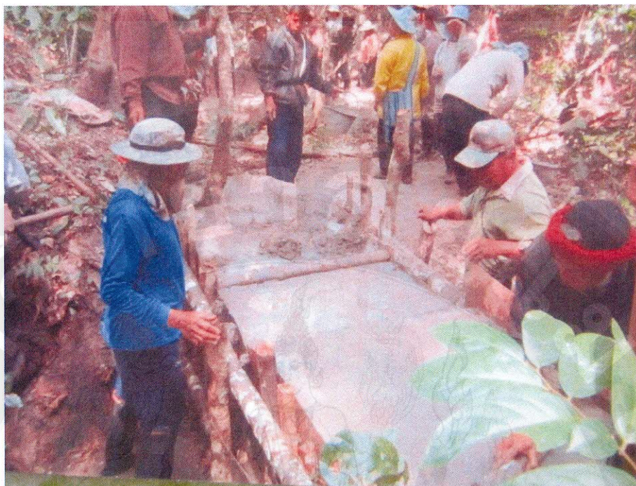
ภาพผนวก 18 สมาชิกในหมู่บ้านช่วยกันทำฝายชะลอน้ำแบบเทซีเมนต์
