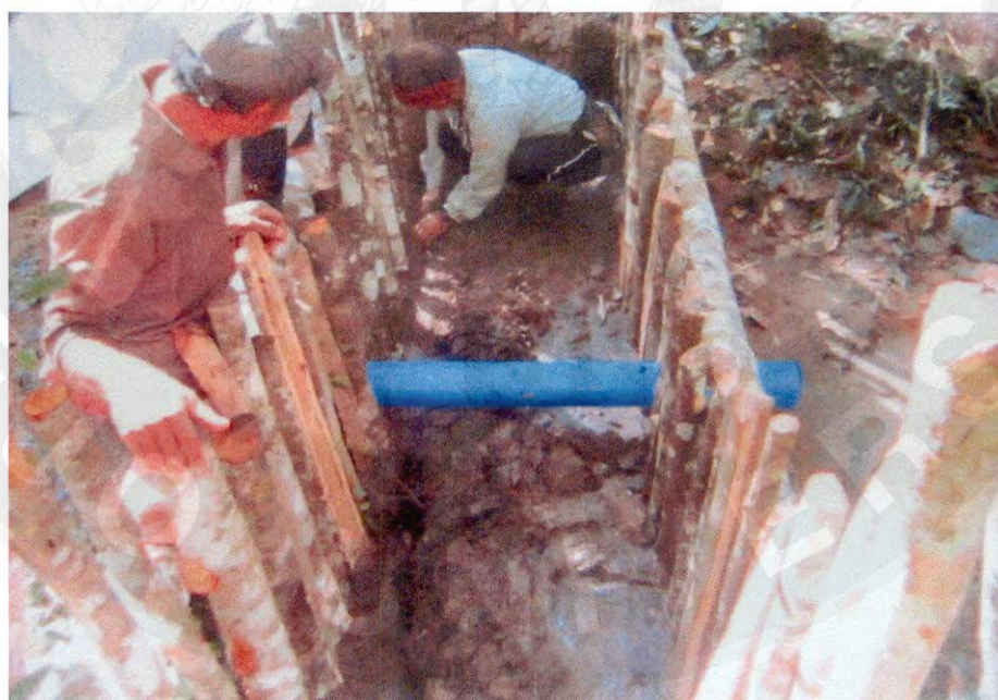
ภาพผนวก 17 สมาชิกในหมู่บ้านช่วยกันทำฝายชะลอน้ำอีกแบบหนึ่ง
