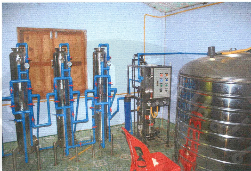
ภาพผนวก 15 ตัวอย่างระบบผลิตน้ำดื่มชุมชนแบบ RO 6,000 ลิตร ต่อวัน
