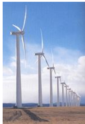
ภาพที่ 8 กังหันลมแบบแนวแกนนอน (Horizontal Axis Wind Turbine)
