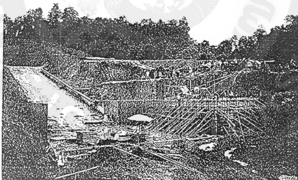
ภาพที่ 16 แสดงขณะก่อสร้างทางระบายน้ำคัน
