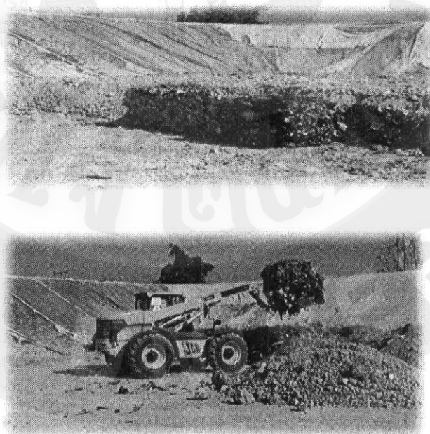
ภาพที่ 7 กระบวนการฝังกลบขยะมูลฝอยเพื่อไม่ให้ส่งกลิ่นและส่งผลกระทบต่อสิ่งแวดล้อม
