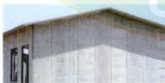
ภาพที่ 13 ภาพผนังคอนกรีตสำเร็จรูป (ที่มา : Ashwatha Contracts Pvt. Ltd, 2017)
