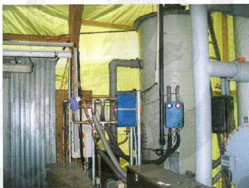
ภาพที่ 2 การติดตั้งระบบกำจัด \text{H}_2\text{S} โดยใช้สาหร่าย
