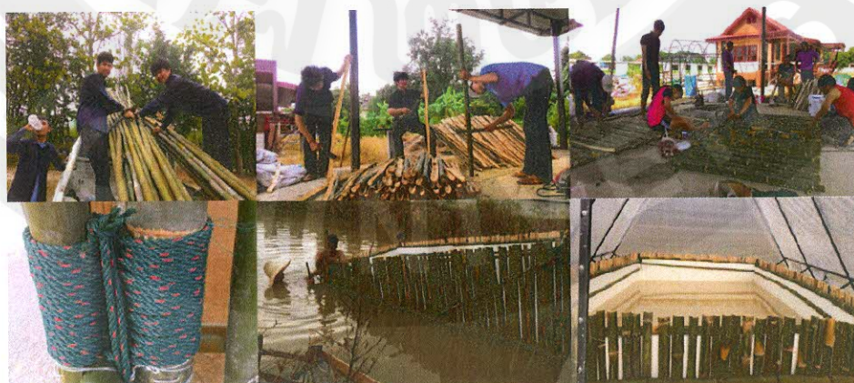
ภาพที่ 17 ลักษณะกระชังเลี้ยงปลาที่มีฉนวนสำหรับลดการสูญเสียความร้อน ออกสู่ภายนอกกระชังเลี้ยงปลาเรือนกระจก
