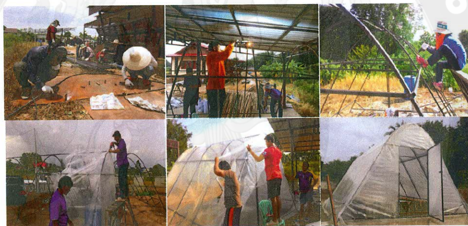
ภาพที่ 16 ลักษณะการสร้างเรือนกระจกสำหรับชุดการทดลองเลี้ยงปลาในกระชัง
